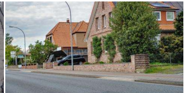
Höhengleich geführter Radweg im Bereich von Zufahrten
