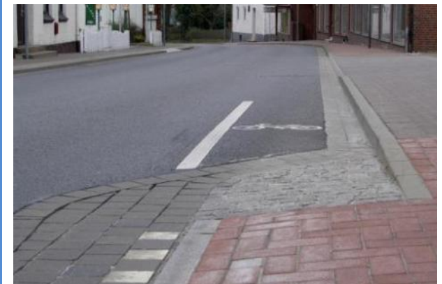
Übergang für Radfahrer vom Gehweg auf die Fahrbahn
