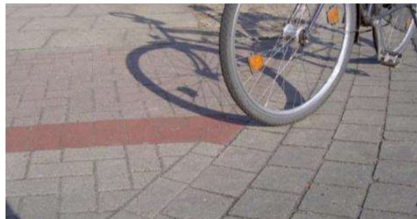
Stoßfreier Übergang von der Straße auf den Radweg
